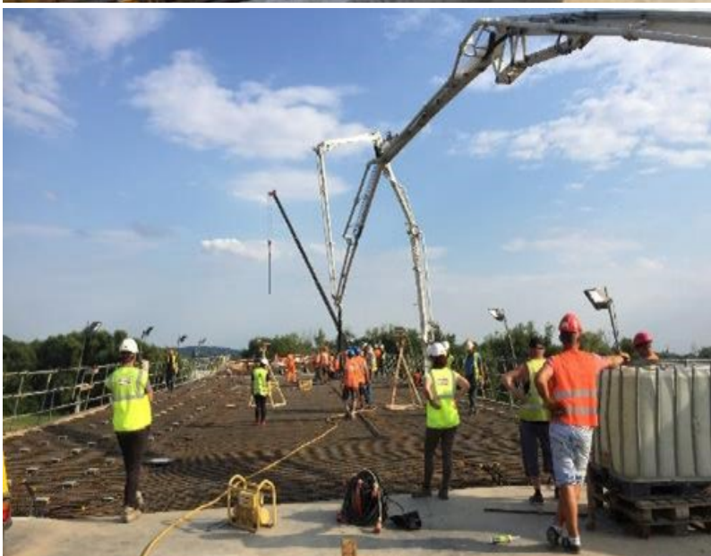
Fot. Prace przy instalacji czujników systemu na budowie obwodnicy Raciborza
