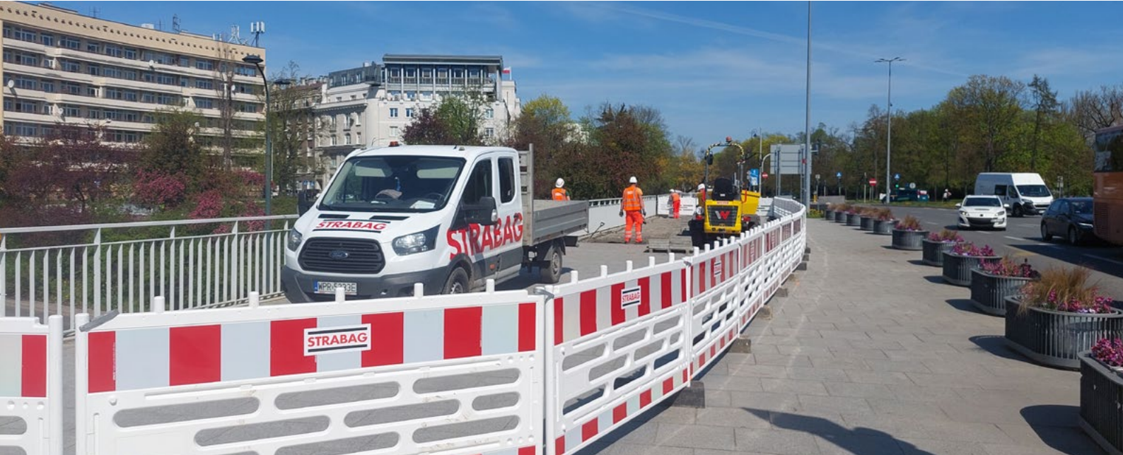
Fot. Początek prac na górnym poziomie placu Na Rozdrożu
