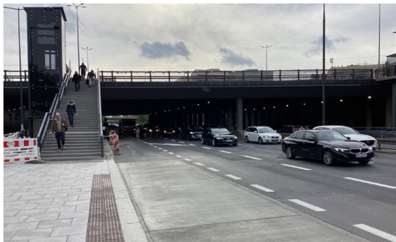
Fot. Montaż szyby windowego oraz widok na nowe schody i windę
