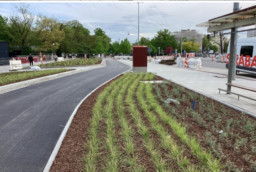
Fot. Placu Na Rozdrożu po przebudowie
