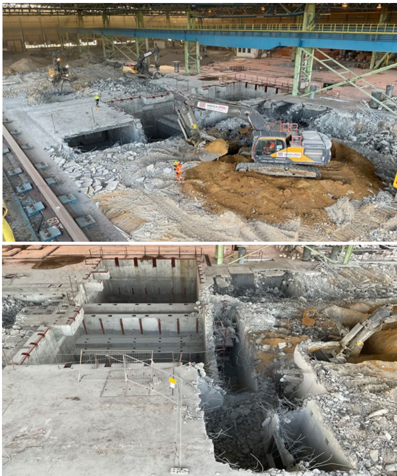
Fot. Początkowa faza budowy i roboty wyburzeniowe w hali nr 1
